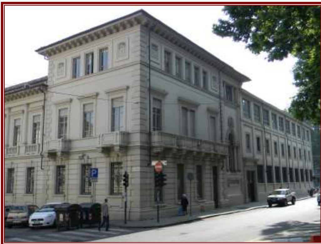
Edificio SEI - Torino
