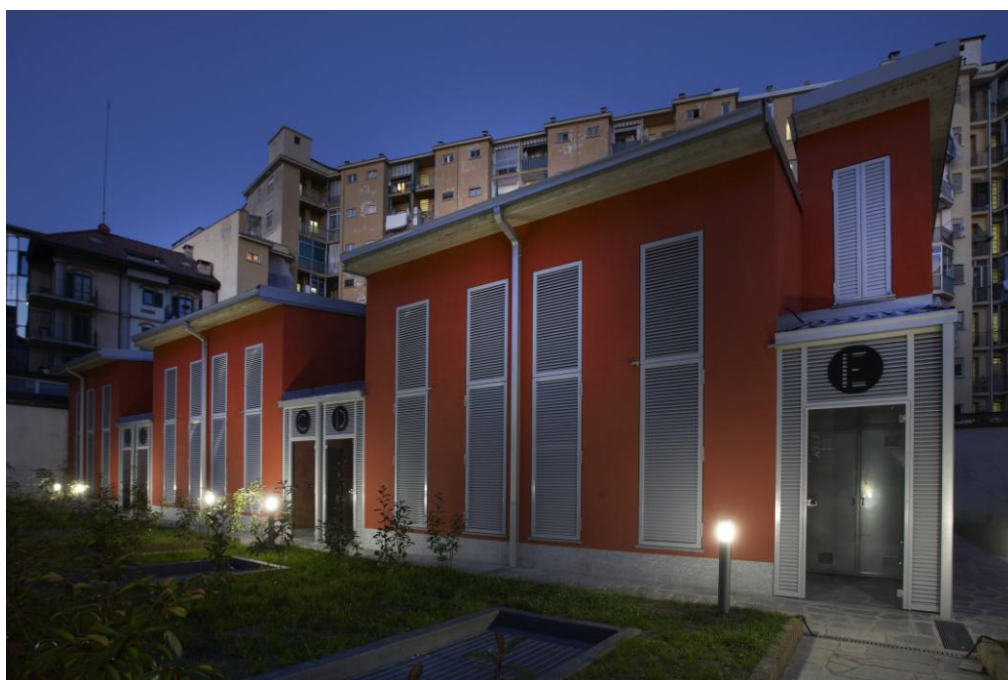
TRASFORMAZIONE DI CAPANNONE IN ALLOGGI IN STRADA DELLA PRONDA
