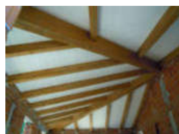
Recupero sottotetto con travi a vista
