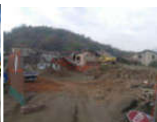
Inizio dei lavori: 10-11-2014
