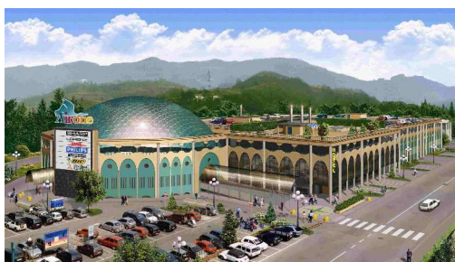
Natura dell'intervento Realizzazione Centro Commerciale Airone
