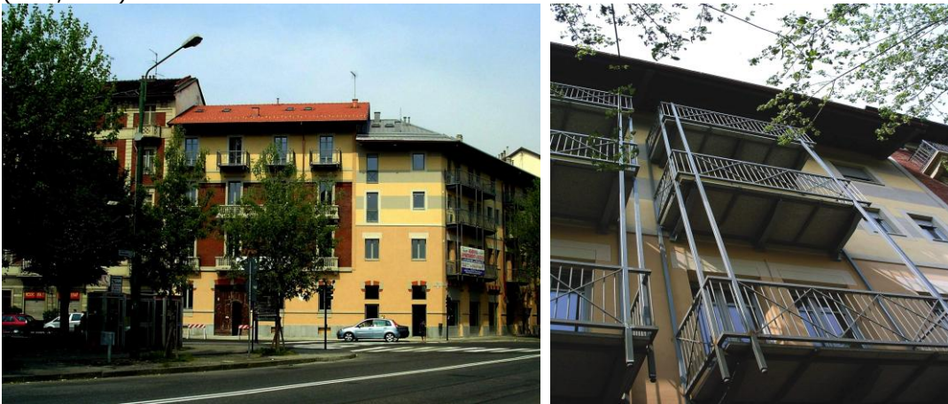
2006-2008 Ristrutturazione con sopraelevazione di edificio liberty in Corso Umbria a Torino (D.P., D.C.)
