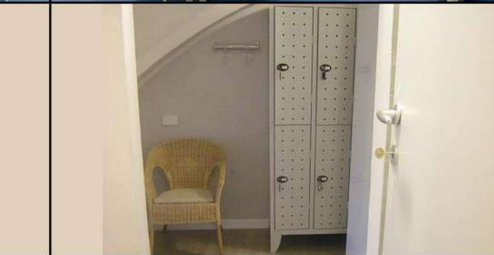
CENTRO PILATES ristrutturazione
