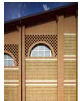
Particolare di facciata
