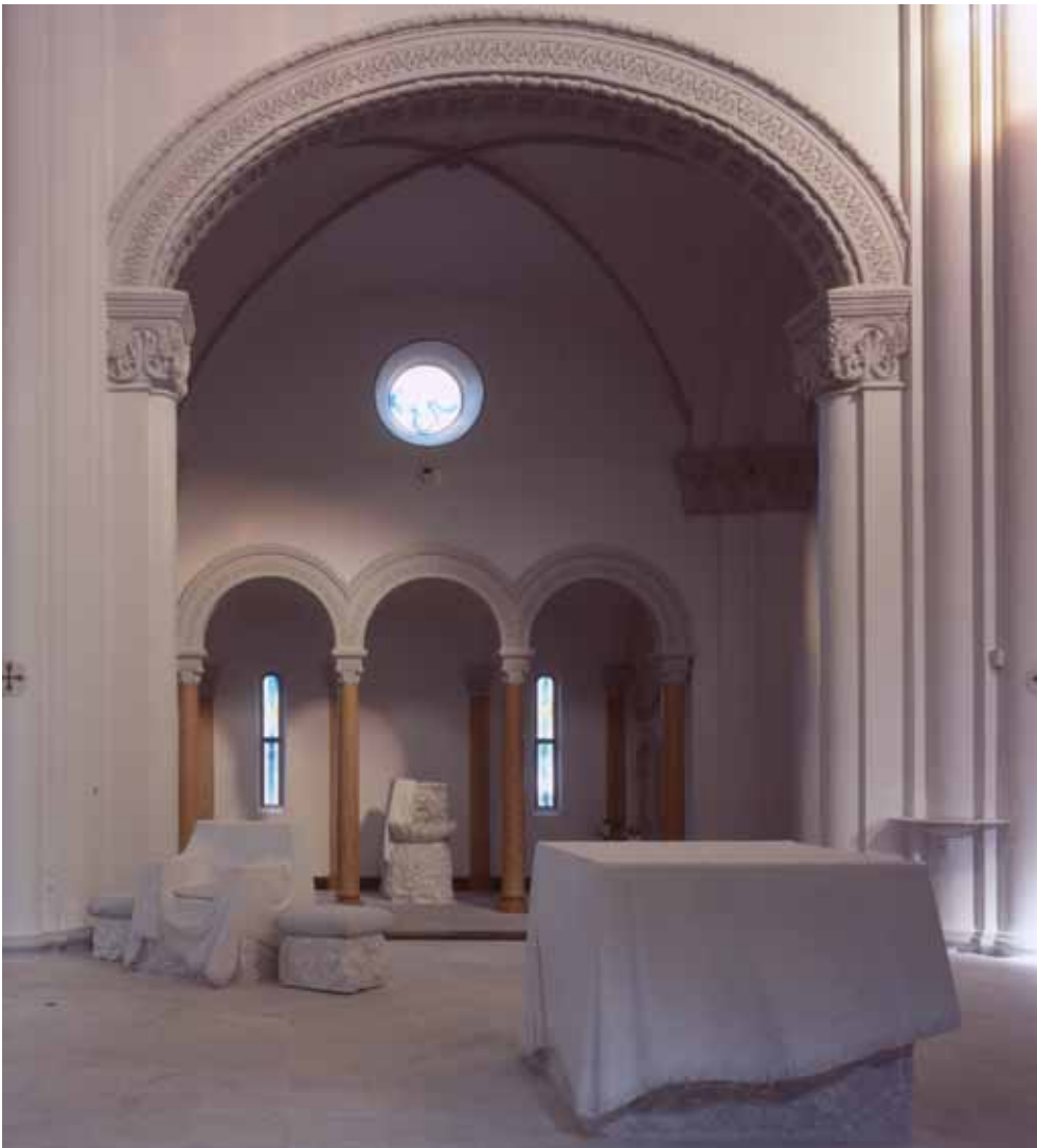
Riapertura arcata laterale all'altezza del transetto
