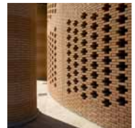
Particolare tamponamento
