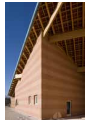
Particolare textura muraria
